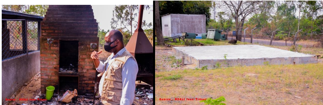
Photos 2 A à gauche : Incinérateur de CUK
