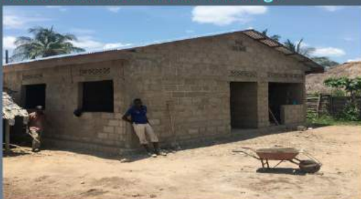
Fondation bâtiment CS Mbelo
