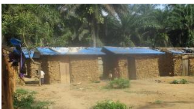
Photo 8: Maisons en pisée dans les campements de Mapiki (gauche) et de Upende -droite) construites avec l'aide des ONG dans le territoire de Mbau au Nord-Kivu.
