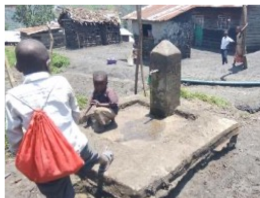
Photo 6 : point de puisage d'eau utilisé par les PA construit par les ONG
