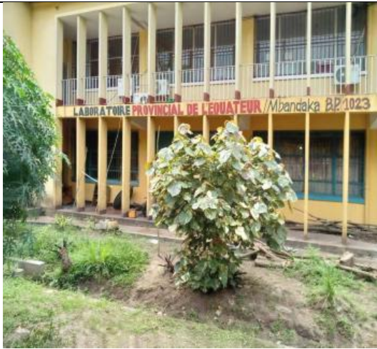
Photo 2: Vue de l'ancien Bâtiment principal du laboratoire
