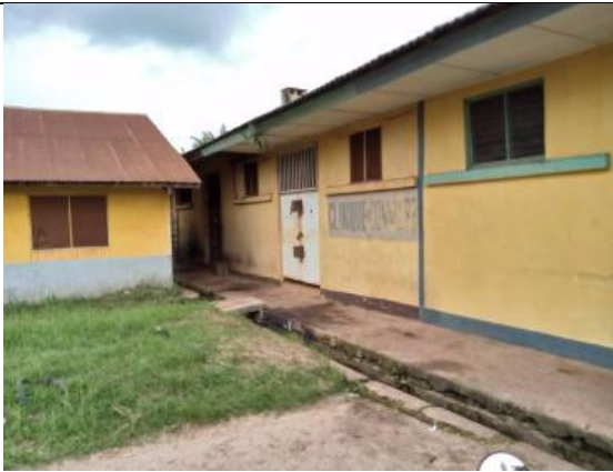
Photo 4: Vu du bâtiment du Bureau de PNLT
