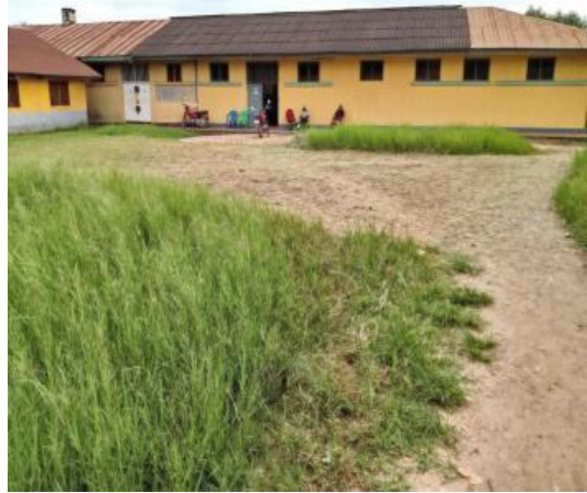
Photo 3: Vu du bâtiment de la banque du sang
