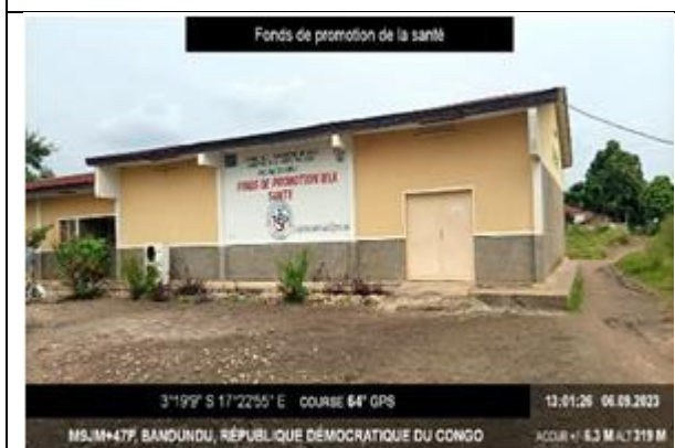
Photo 10: Bâtiment abritant deux services provinciaux dont FPS, CAMEBASU
