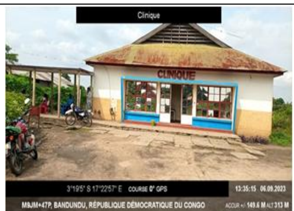
Photo 9: Ancienne clinique de l'Hôpital Général de Bandundu Ville
